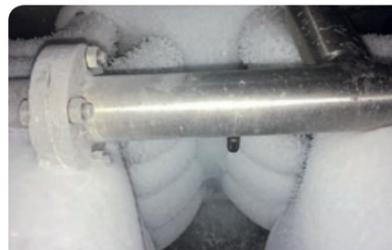
Abb.: Kondensator mit Eisbelegung
