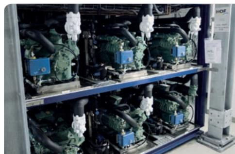
Abb.: Modulaufbau von sechs Kompressoren
